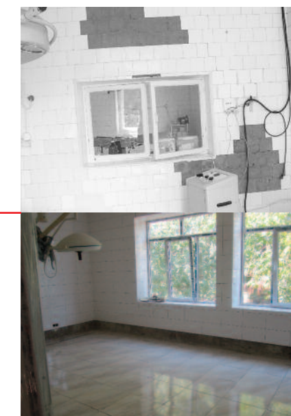
Der Schwerpunkt lag auf der Sanierung des desolaten OP-Traktes.
