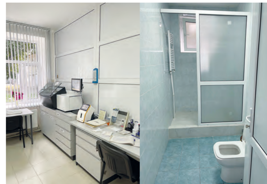
Moderne Laborgeräte für qualitativ hochstehende Analysen Sanierung der sanitären Anlagen
